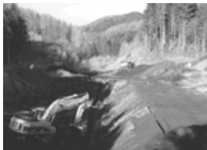
着々と進む、最終処分場の増設事業（青葉町有地内）
