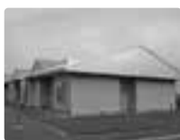
さくらんぼ団地(公営住宅)
