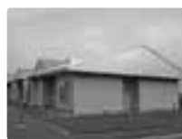
さくらんぼ団地 (公営住宅)
