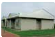
さくらんぼ団地 (公営住宅)
